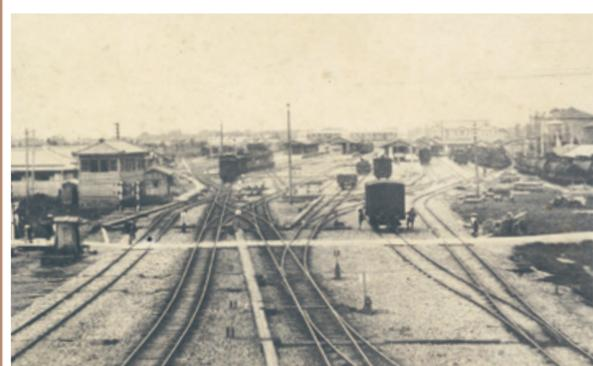
新津停車場(現新津駅)構内。0番線(写真右)の隣には石油運搬のための引込線が設けられ、製油所から運ばれた石油を保管するタンクが建てられました。引込線には油槽車が数多く並んでいます。
