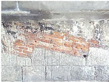
信越本線 車場川橋梁 ねじりまんぼ。 下部は石造りになっていて、波形で接合されている珍しいねじりまんぼ。 傾斜角は75度。
