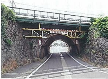
信越本線 車場川橋梁 ねじりまんぼ。 1897年(明治30年)11月20日 場所：新潟県新潟市秋葉区車場1丁目11 信越本線 亀田駅-荻川駅間。 2016年06月18日探索。
