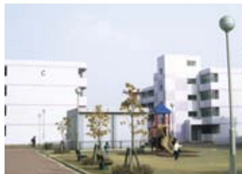
藤見町第2住宅
