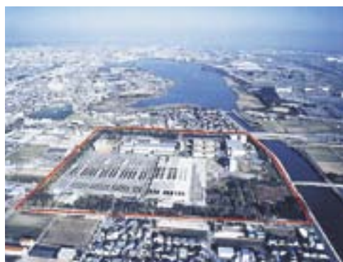
中部下水処理場
