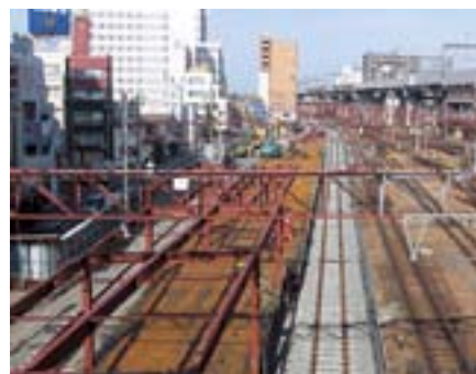
整備中の仮ホーム(新潟駅8・9番線)
