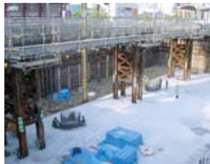
白山駅工事状況 (新潟駅周辺整備事務所)
