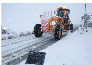
車道除雪の状況
