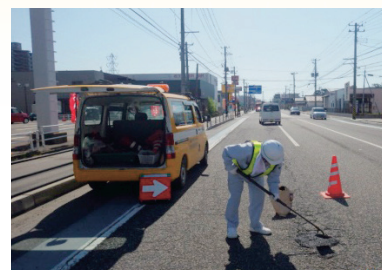
舗装補修の状況
