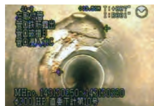
管の破損
