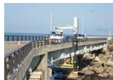
橋梁点検の状況
