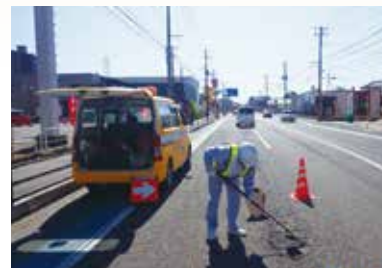
舗装補修の状況
