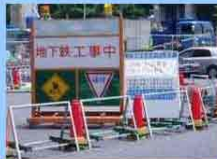
占用工事とわかるように「地下鉄工事中」と表示している。
