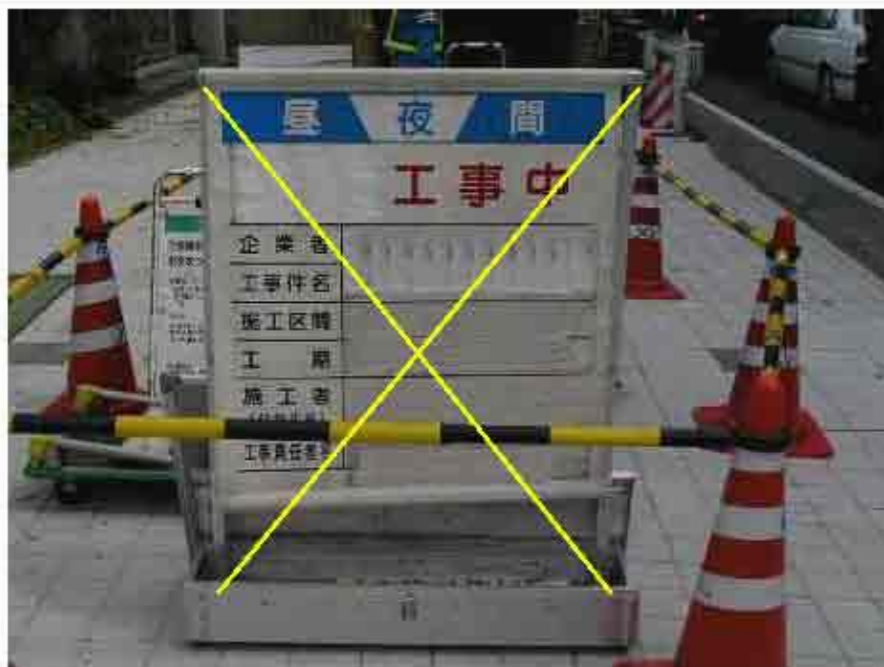
○工事中看板が従来の工事標示板となっている。
