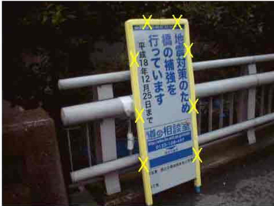
○緩衝材（ソフトカバー）が看板の色調とあっていない（青色または白色）。
