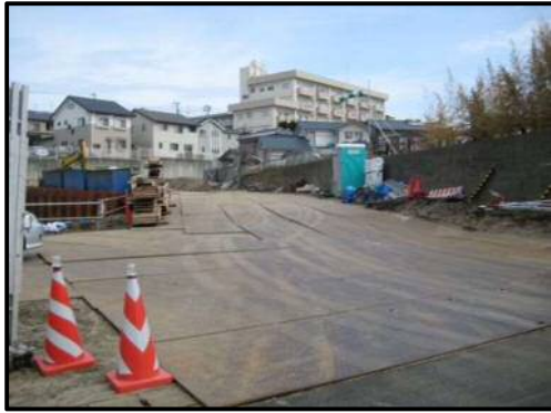
【写真 9】搬入車両出入口 (予定のスロープ)
