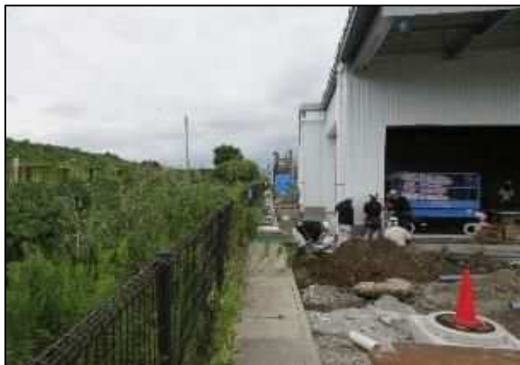
【写真⑪】建物1北側
