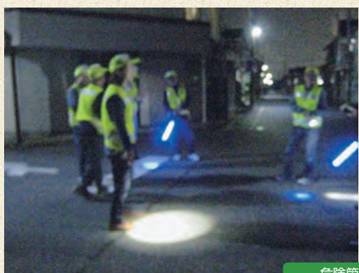
危険箇所の点検
