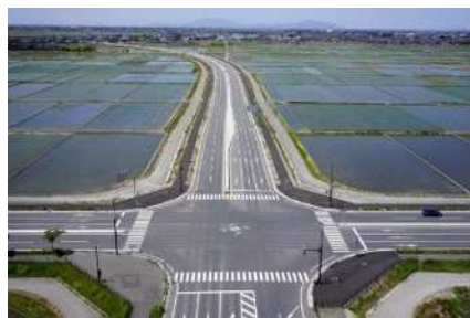
新潟中央環状道路 横越バイパス
