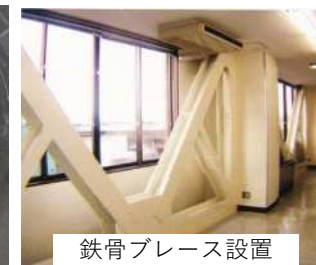
下水処理場の耐震化
