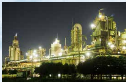
▲通船川鷗橋付近の工場夜景
