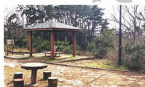
西池を見下ろす東屋
