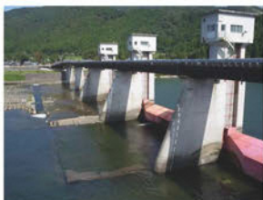
阿賀野川頭首工
