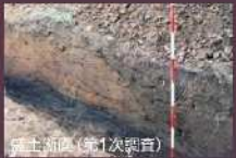
盛土断面 (第1次調査)
