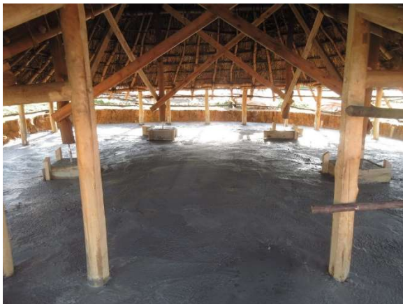
土間・周堤下コンクリートのベタ基礎新設 (1号棟)
