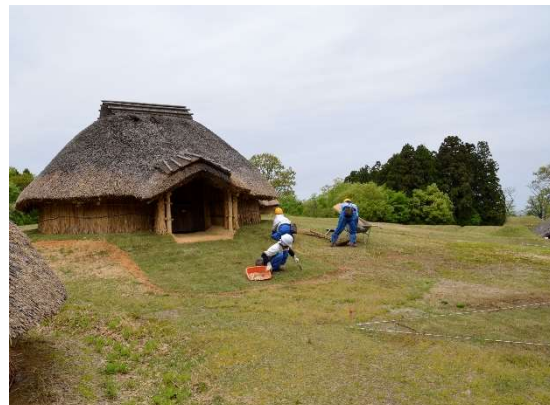
芝生修繕作業風景 (令和5年4月)
