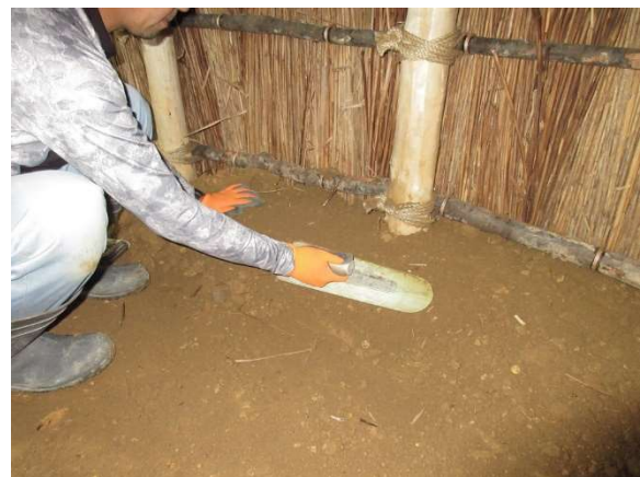
土間・周堤の復旧 (1号棟)
