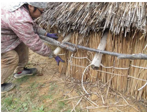
茅葺の復旧 (1号棟)
