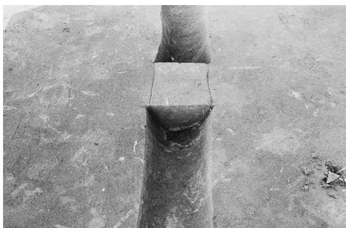
SD70 土層断面 A-A' (南西から)
