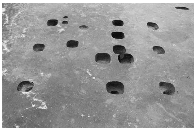
SB2001 完掘状況（北東から）
