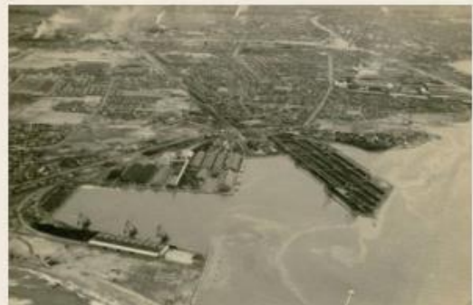
建設中の臨港埠頭 (大正時代後期)
