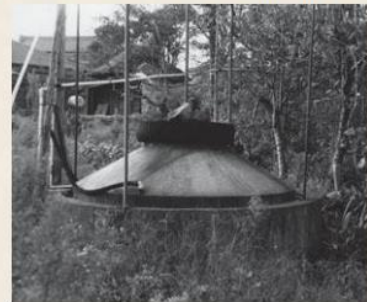
自家用の天然ガスタンク (昭和59年、中央区女池付近)
