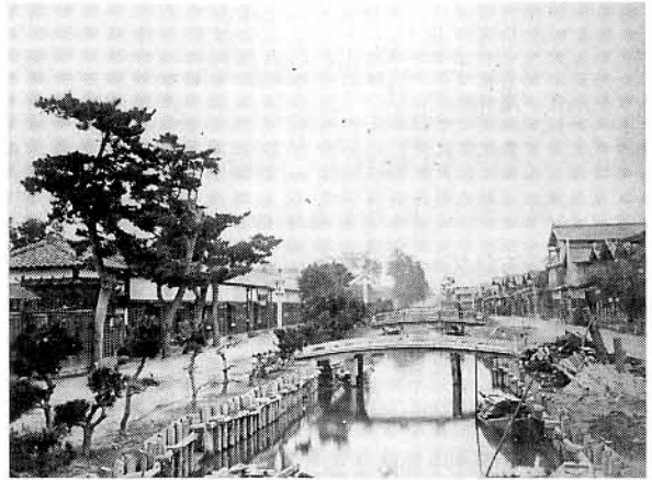
(写真1) 西堀の榎谷小路付近
