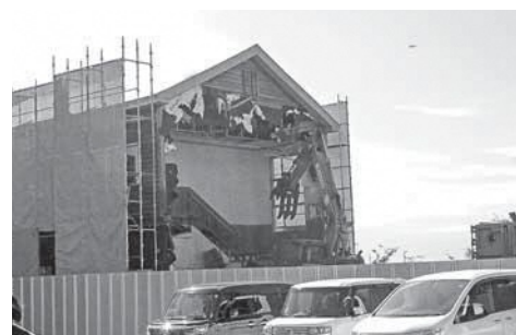
建物の解体（10月）
