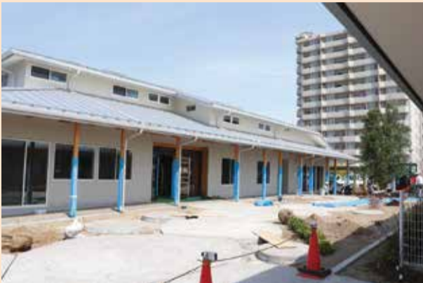
建設中の曾野木コミュニティセンター
