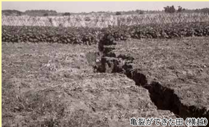
崩壊した排水路(亀田)
