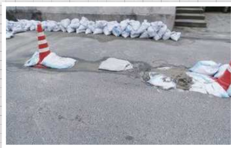
道路のいたるところで陥没や亀裂が発生
