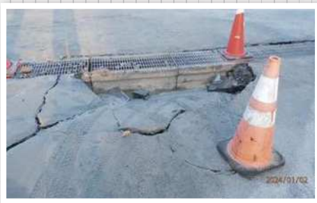
道路のいたるところで陥没や亀裂が発生
