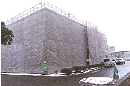
農村環境改善センターの改修工事
