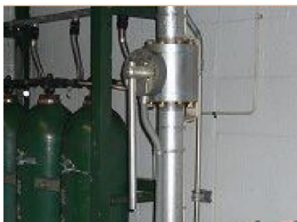
集合管に閉止弁を設置した例
