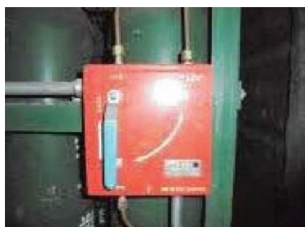
操作管に閉止弁を設置した例
