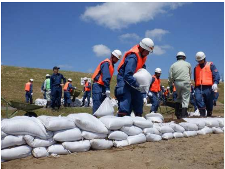
④土のうを積み込み
