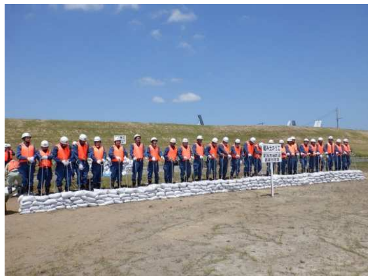
⑥積み土のう工法完成
