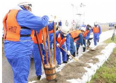
積み土のう工
