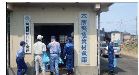
本所緊急資材備蓄倉庫
