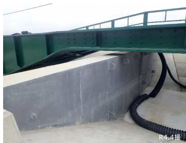
橋梁の架替部、特殊堤(川裏)
