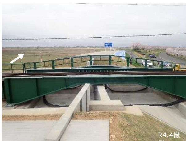
橋梁の架替部、特殊堤(上流より)
