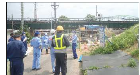
阿賀野市下里(羽越本線鉄橋)
