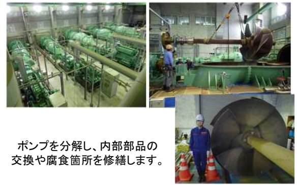
(4号)主ポンプ・主原動機分解整備
