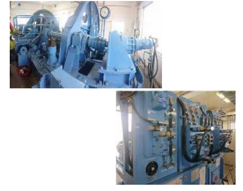
ゲートの安全動作を確保するための修繕を行う。
