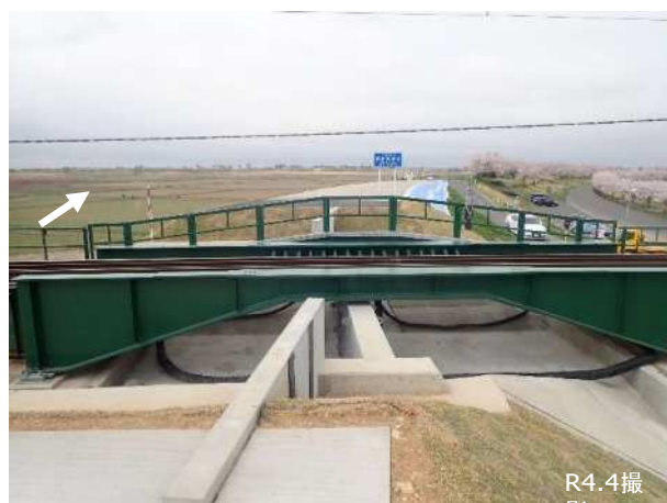
橋梁の架替部、特殊堤(上流より)
