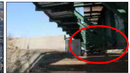
堤防との交差部の様子
