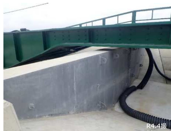
橋梁の架替部、特殊堤(川裏)
