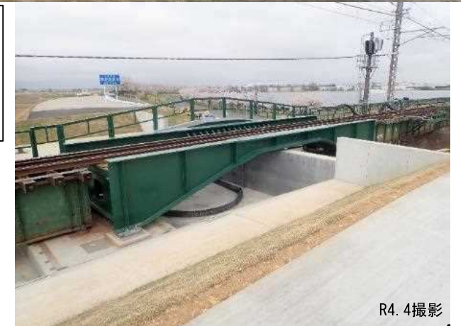
橋梁部分架替・特殊堤の整備状況
