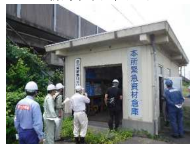
本所緊急資材備蓄倉庫
