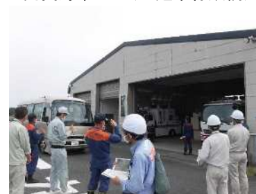
中新田災害対策機械等格納庫
