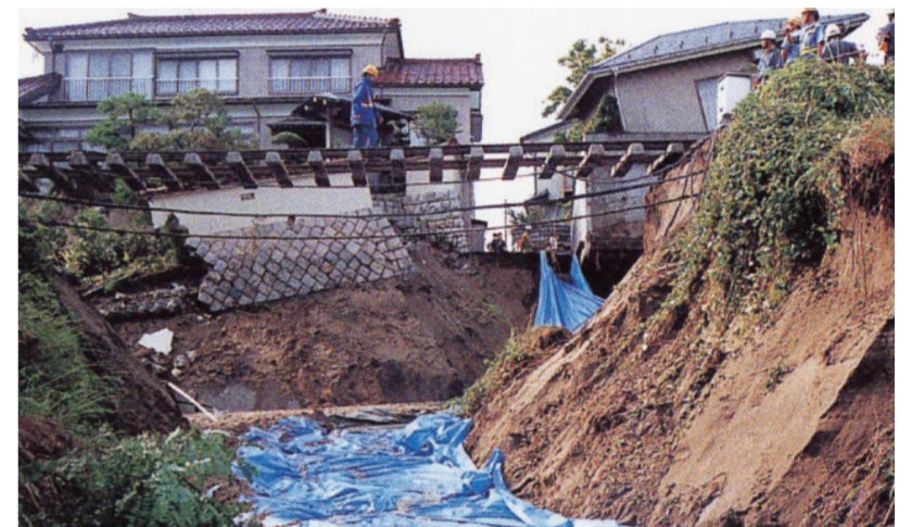
市内の市街地で集中豪雨によりがけ崩れが発生したものです。
