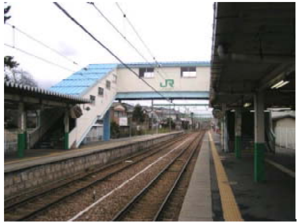
写真3.1 階段のみの連絡橋
