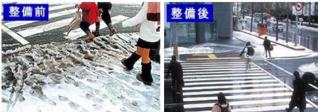
写真4.4～5 冬期における取り組み事例（融雪装置の設置）
