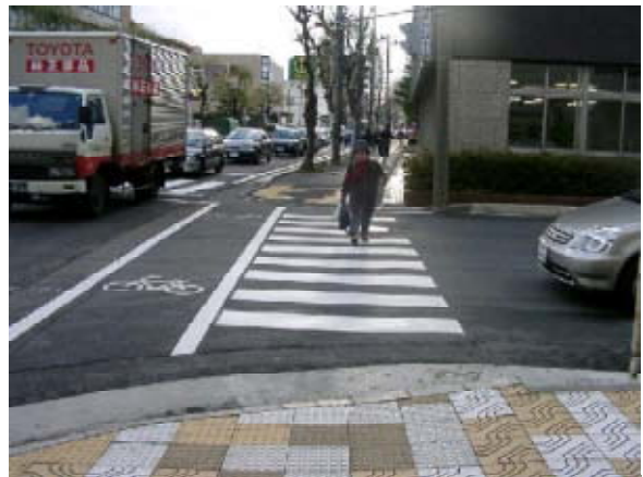
写真3.10 歩行者用信号機が設置 されていない横断歩道
