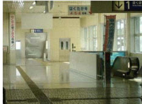
写真5.12 エレベーターとエスカレーターの設置事例
