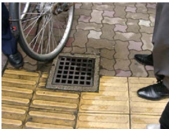
写真5.7 誘導用ブロック
