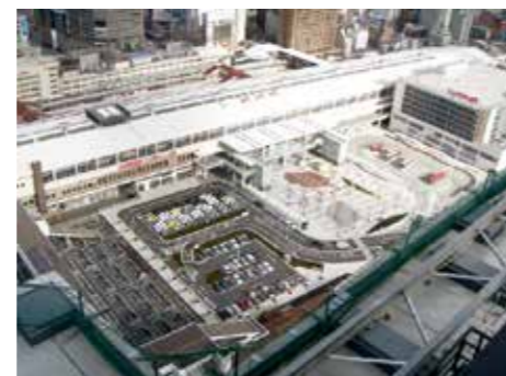
新潟駅南口広場 (平成 21 年度第 1 期工事終了)
