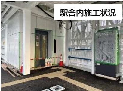
外壁設置工事
