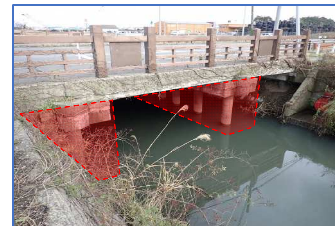
橋脚部補修範囲
