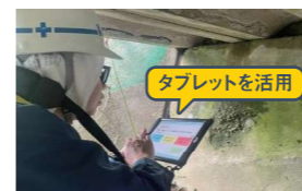
小規模な橋の点検状況
