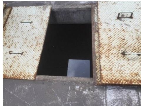
(左：ヤード周辺に排水溝を設置、右：油水分離槽の設置)
