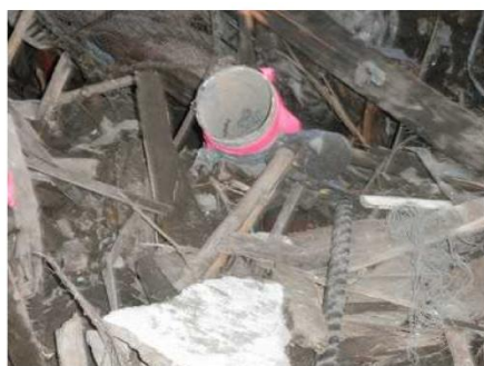
火災予防対策（ガス抜き管の設置） 岩手県宮古市宮古運動公園二次仮置場
