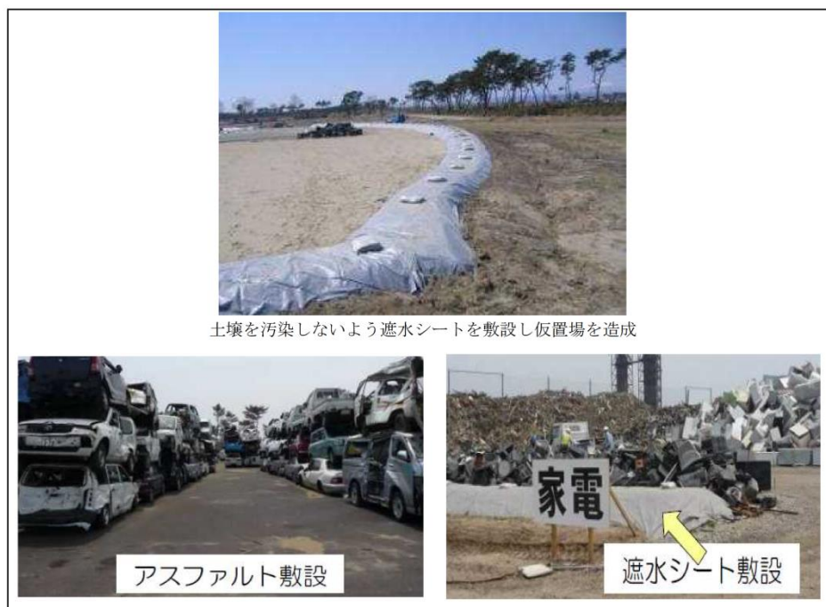
廃棄物仮置き前に地下浸透防止対策を実施した例(仙台市)
