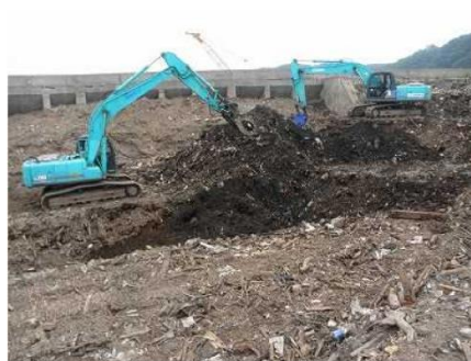
重機による災害廃棄物の山の掘削 岩手県宮古市田老一次仮置場
