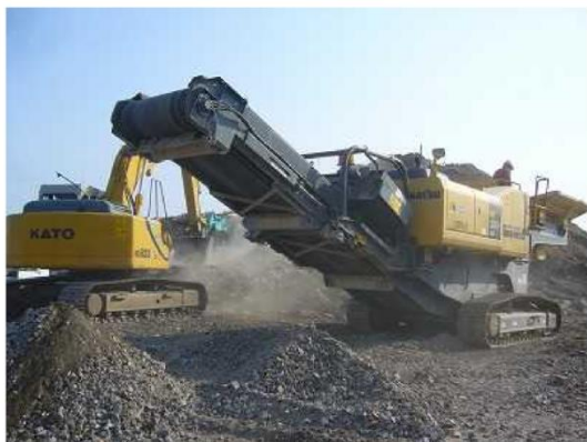
移動式コンクリート破碎機
