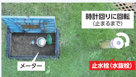
メーターボックスの外にある止水栓
