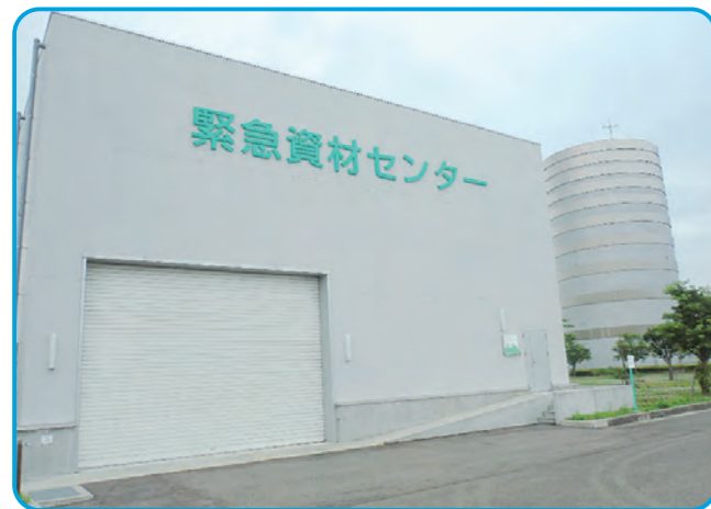
緊急資材センター（信濃川浄水場）
