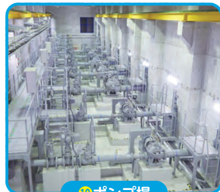
⑩ ポンプ場
