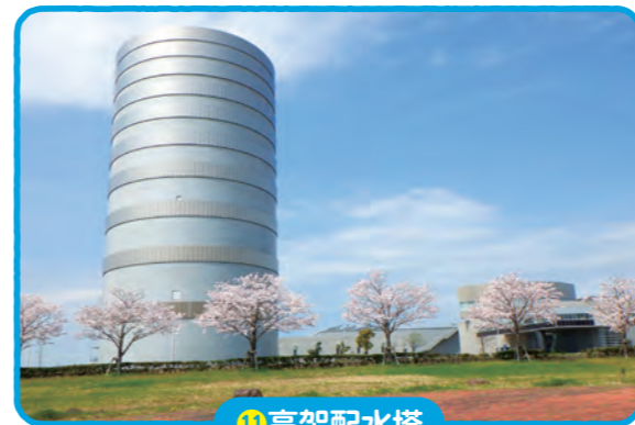
⑪ 高架配水塔
