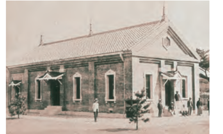
創設時の関屋ポンプ室
