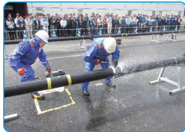
緊急復旧の訓練
