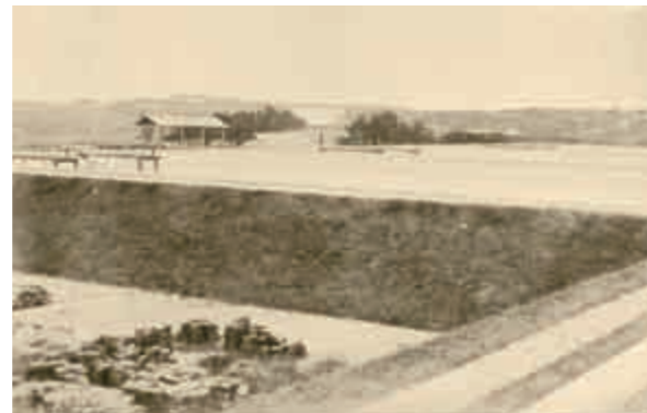
工事中の関屋浄水所沈でん池
