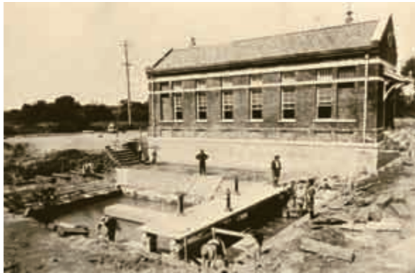
工事中の小新砂溜池
