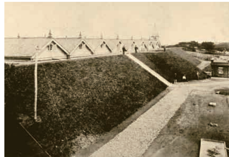
南山配水所の浄水池
