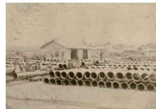
積み置きされた大量の鉄管
