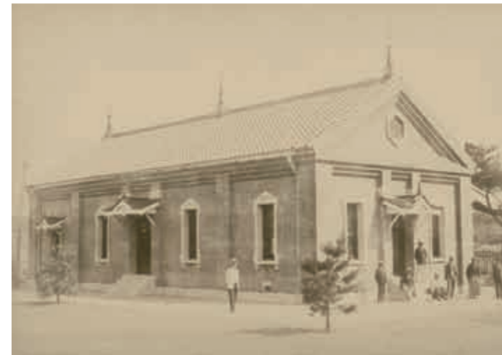
関屋浄水所のポンプ場
