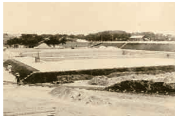
工事中の関屋浄水所ろ過池
