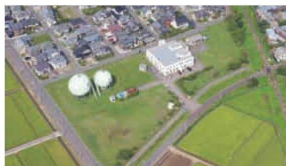
現在の西川浄水場
