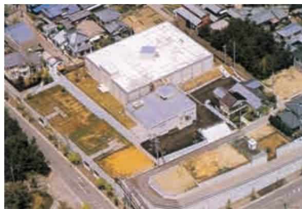
大規模な改良が行われた内野配水場
