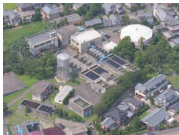
亀田浄水場(平成20年2月14日稼働停止)
