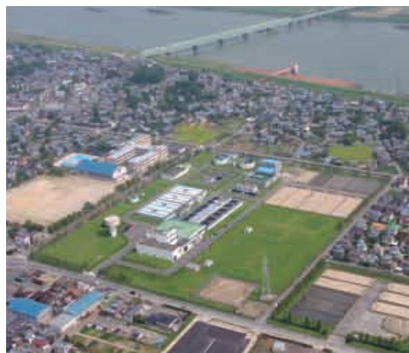
増強された阿賀野川浄水場
