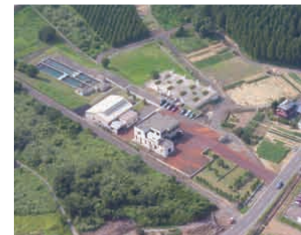
現在の岩室浄水場
