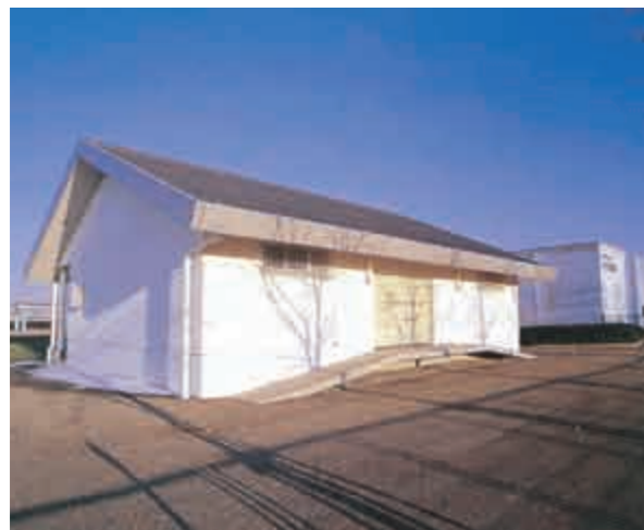
竹尾配水場の緊急給水センター
