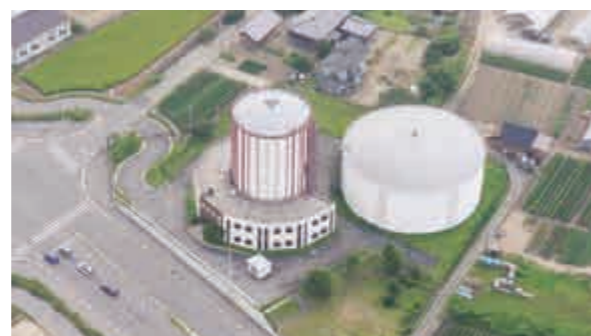
現在の内島見配水場
