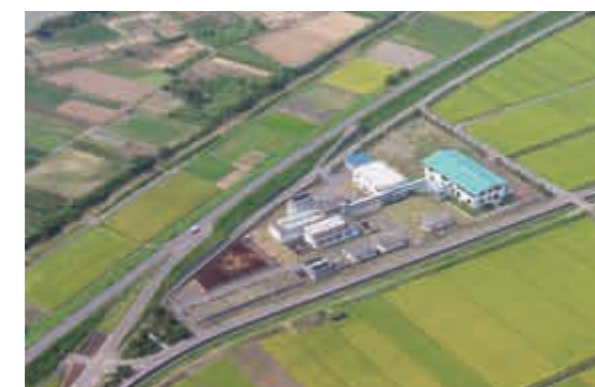
小須戸浄水場(平成22年2月16日稼働停止)
