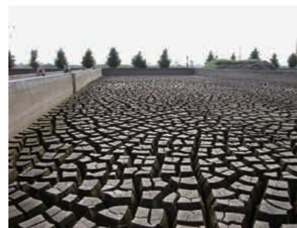
阿賀野川浄水場の天日乾燥床
