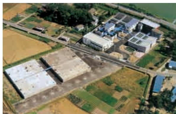
黒埼浄水場(平成14年3月1日稼働停止)
