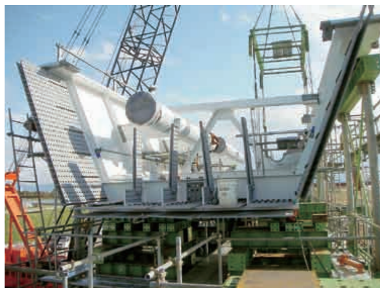
ござれや阿賀橋添架管工事
