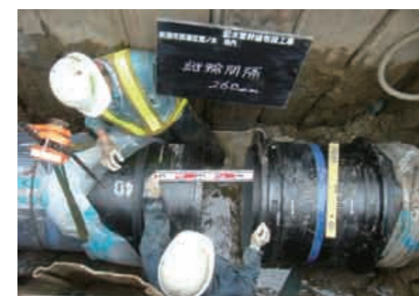
100年管網を目指し高性能ダクタイル鉄管を布設
