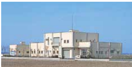
■図-21 新潟市両川浄化センター
