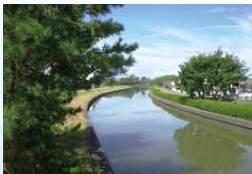
■図-19 西川 (西区開新橋より)
