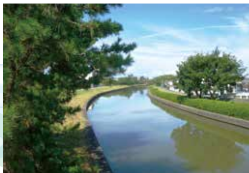
■図-19 西川(西区開新橋より)
